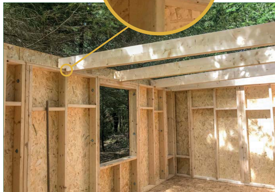
Fig.10 : Entailles des poutres pour créer la pente
