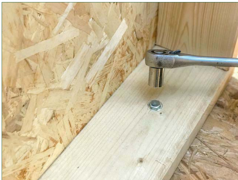
Fig.2 : Trous de perçage et goujons d'encrage
