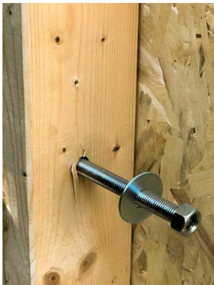
Fig.5 : Boulon de serrage de deux montants
