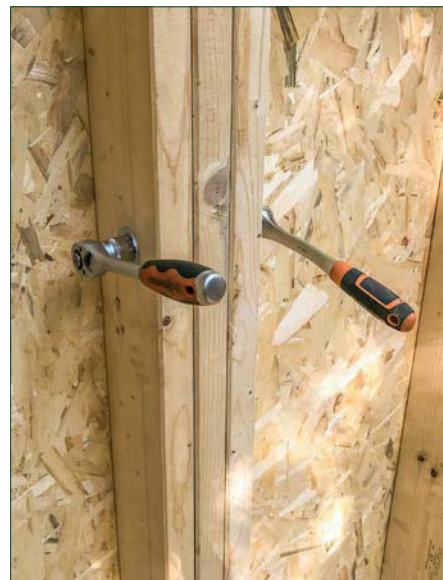
Fig.6 : Serrage d'un boulon avec clefs de 22mm
