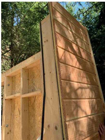
Fig.3 : Pose de la première bande adhésive
