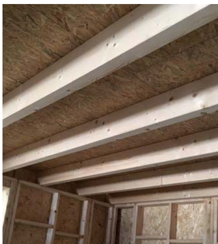
Fig.12 : Structure OSB vue du dessous
